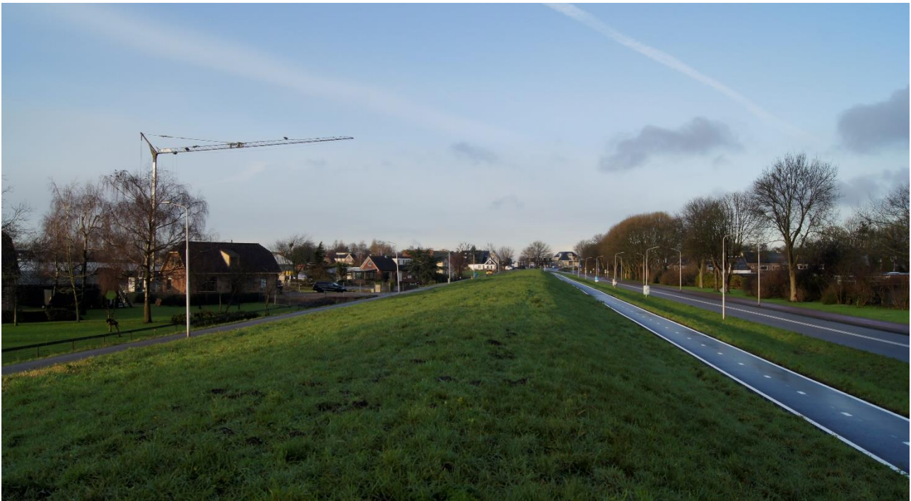
Figuur 8. De liniedijk met fietspad (hoofdverdedigingslijn)
